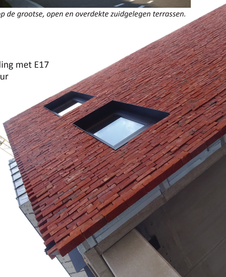
Op kolen gestookte ringoven stenen weerspiegelen dankzij de verlijming een duurzaam en tijdloos karakter.
