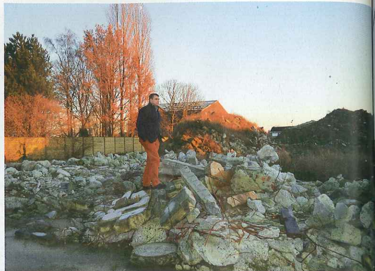
Projectontwikkelaar Hendrik De Keukeleire kijkt verwachtingsvol uit over de bouwplaats.
