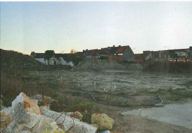
Om het terrein bouwrijp te maken, was een grondwatersanering nodig. Meer beelden vind je op www.bouwkroniek.be in de rubriek Redactioneel.
