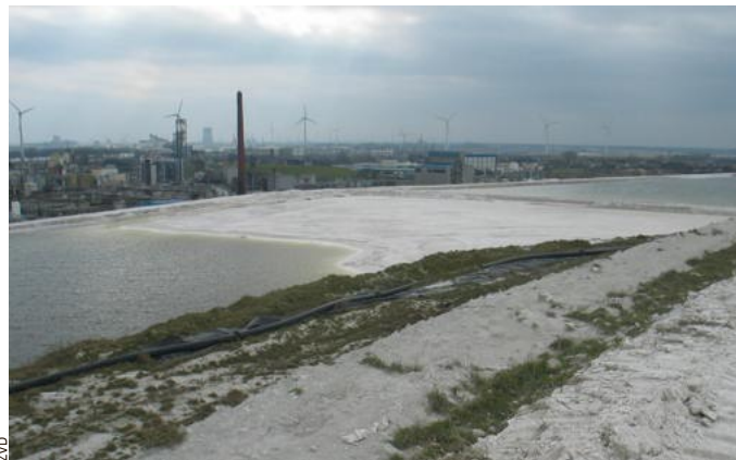
■ Vijf jaar geleden dreigden bekkens met zuur water door te breken.
