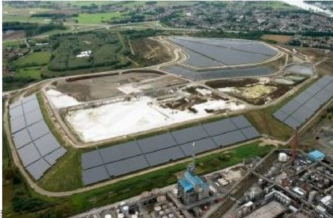
■ De berg is voor twee derde afgedekt en er kwamen al 55.000 zonnepanelen.
